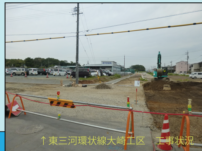
↑東三河環状線大崎工区 工事状況
